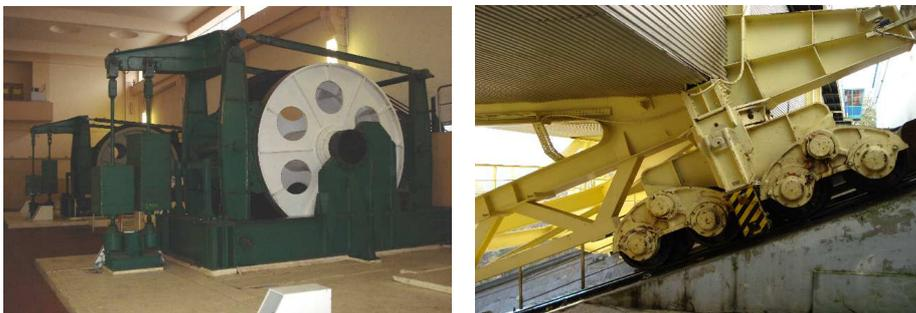
Une étude réalisée par un bureau d'études spécialisé est prévue. Cet équipement a pour fonction de répartir la charge sur les 28 câbles et d'éviter la rupture de câbles en rafale en reportant instantanément la charge sur les 27 câbles restants.
